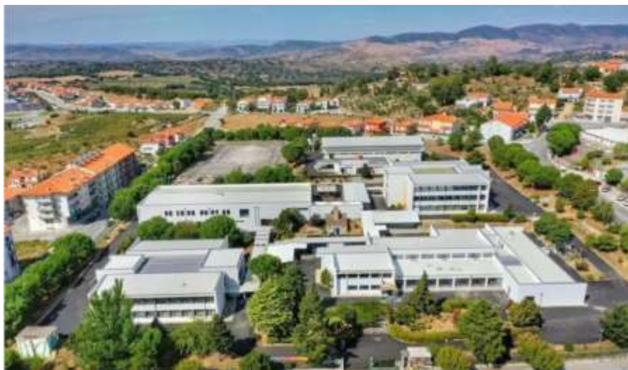
Figura 1 – Vista Aérea do Agrupamento de Escolas de Pinhel
