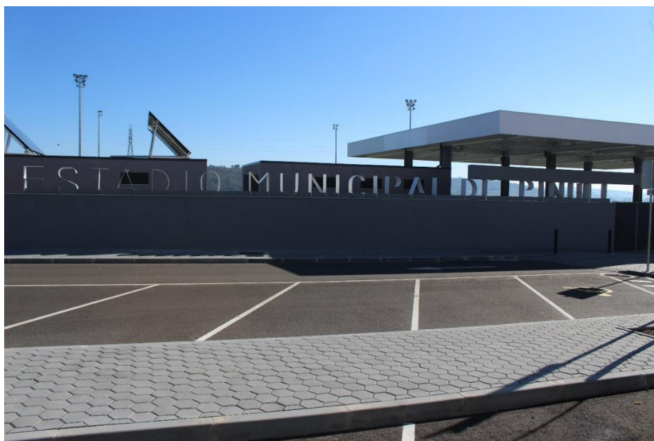
Figura 1 – Estádio Municipal de Pinhel
