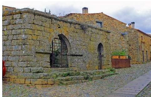
Figura 4 – Poço da cisterna
